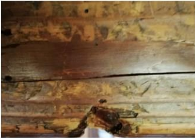
Stubenbalken mit GP 11 - Kerbe
